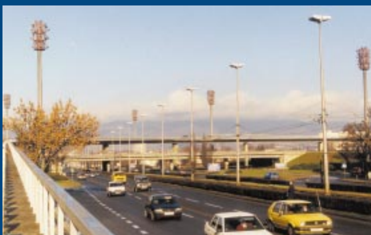
KORS 2B Rasvjetni stupovi KORS 2B Lighting poles
