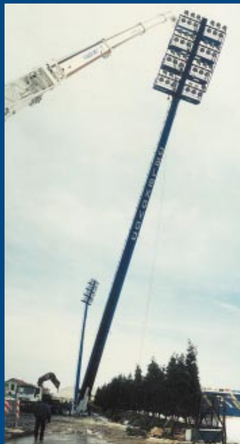
SUN Rasvjetni stupovi SUN Lighting poles
