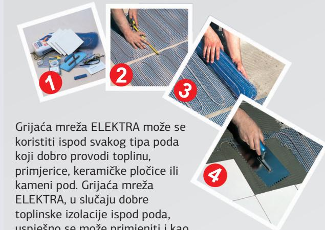
Grijaća mreža ELEKTRA može se koristiti ispod svakog tipa poda koji dobro provodi toplinu, primjerice, keramičke pločice ili kameni pod. Grijaća mreža ELEKTRA, u slučaju dobre toplinske izolacije ispod poda, uspješno se može primjeniti i kao osnovni sustav grijanja.
