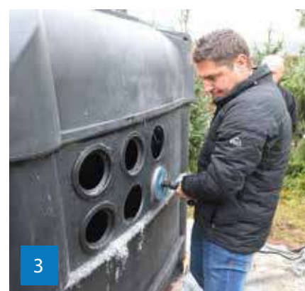
3 Izvedba priključaka na okno.
