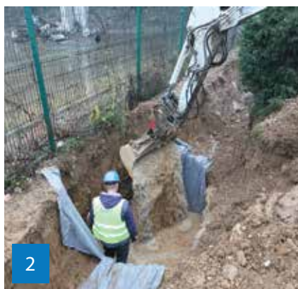
2 Nasipanje materijala za posteljicu okna.
