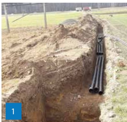
1 Priprema ugradbene jame.
